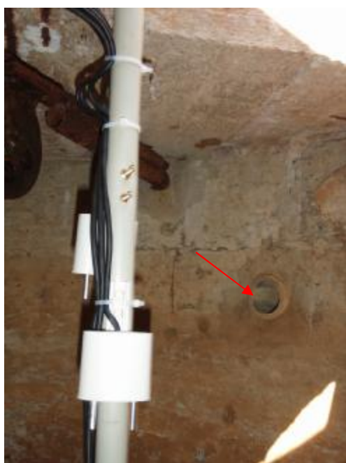
Obrázek 4 - Detail přepadového otvoru
