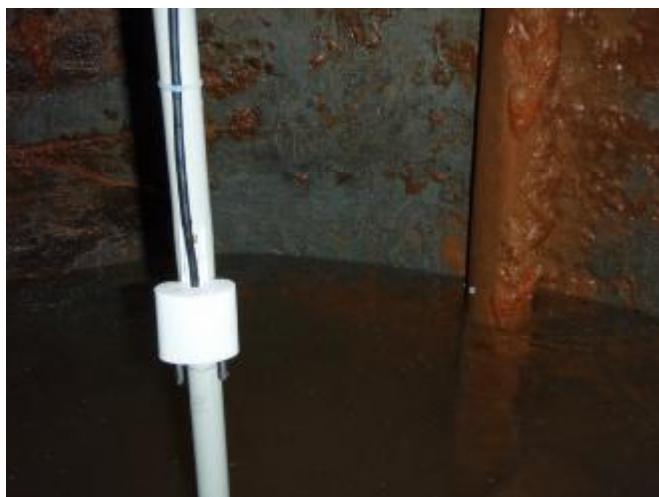
Obrázek 2 - Sonda dolní kritické hladiny
